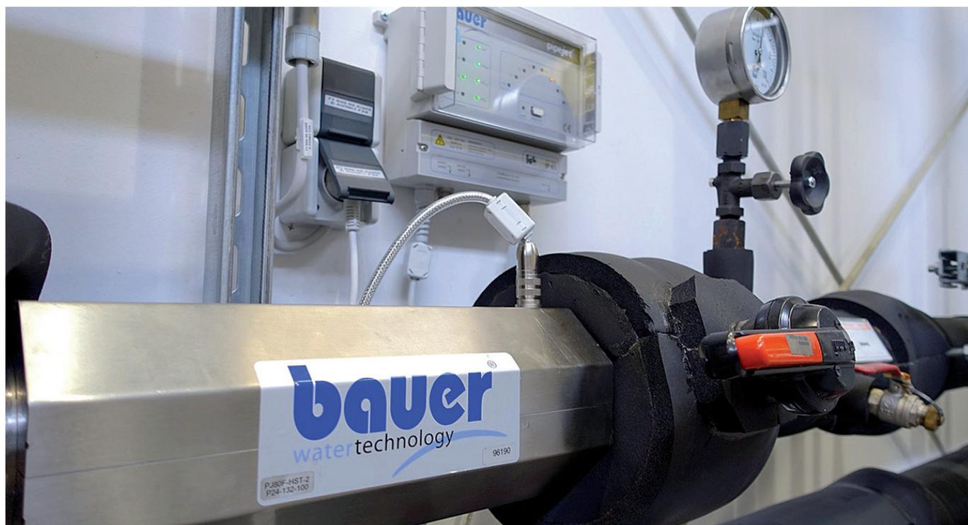
Einbau im zentralen Vorlauf: Wasserbehandlung mit Steuergerät
